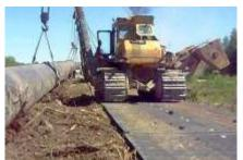
Мобильные (плиты) дорожные покрытия Нанотехнологического производства центра композитов были применены при замене магистрального участка газопровода Западной Сибири.
