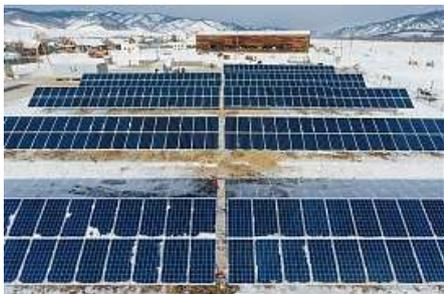
Первую в Забайкалье автономную гибридную электроустановку, состоящую из солнечных модулей и дизельных генераторов, запустили в селе Менза Красночикойского района Забайкальского края. В создании системы управления литий-ионными АКБ в энергоустановке принял участие резидент технопарка «Жигулёвская долина» ООО «Системы управления хранением энергии» (ООО «СУХЭ»).
